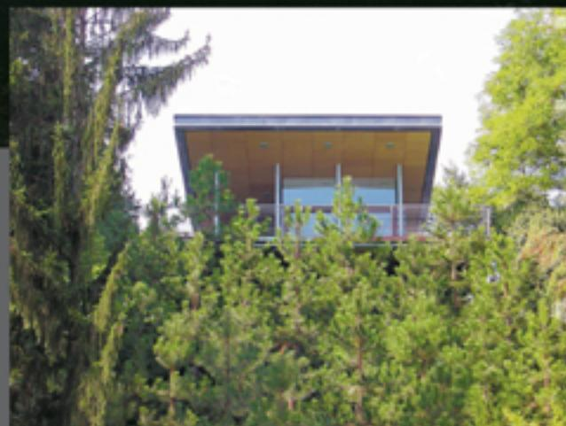
**3** Veduta della "dacia" dalla base del pendio: l'intervento ha richiesto una soluzione strutturale "leggera" a telaio in acciaio sorretta da un sistema a pali infissi in profondità per non alterare l'equilibrio statico del pendio
